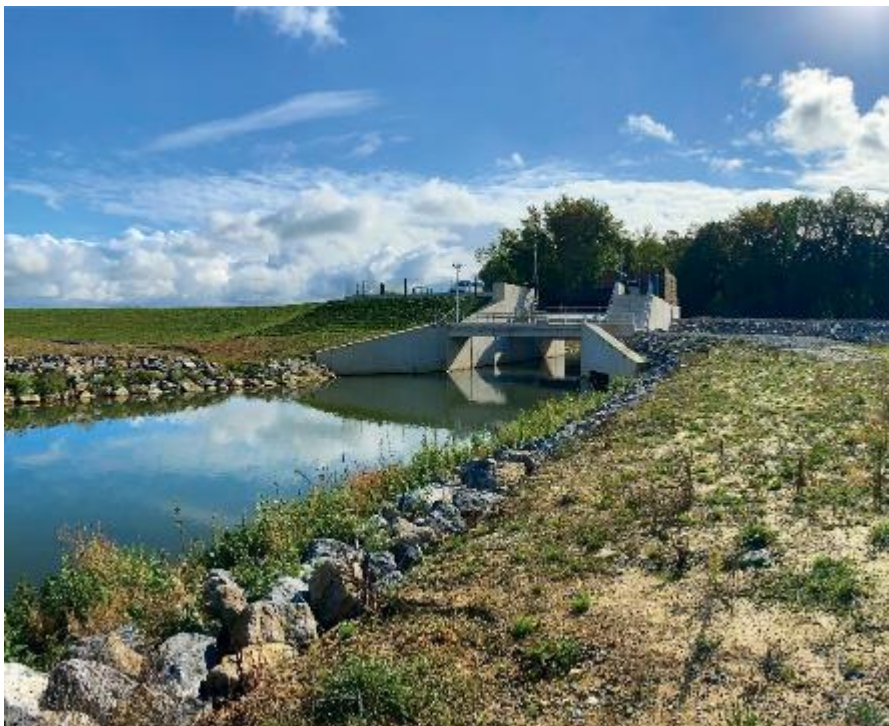
Photo de l'ouvrage après travaux Source : Entente Oise-Aisne
