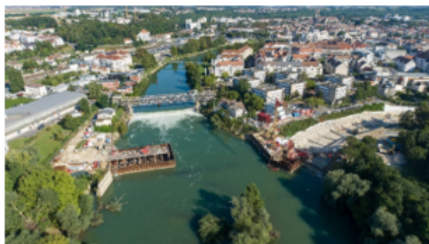
Vue aérienne des travaux. A droite : l'emplacement de la passe
